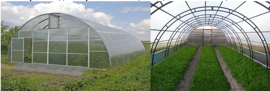
Рис. 2.2.2. Теплица из поликарбоната размером 20х30 кв. метров
